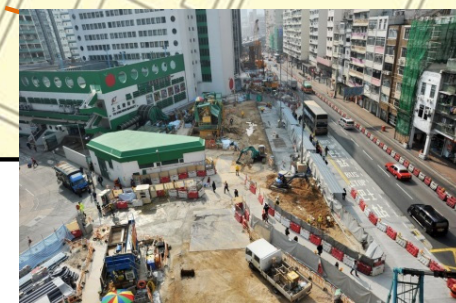
馬頭圍道工地現況。
