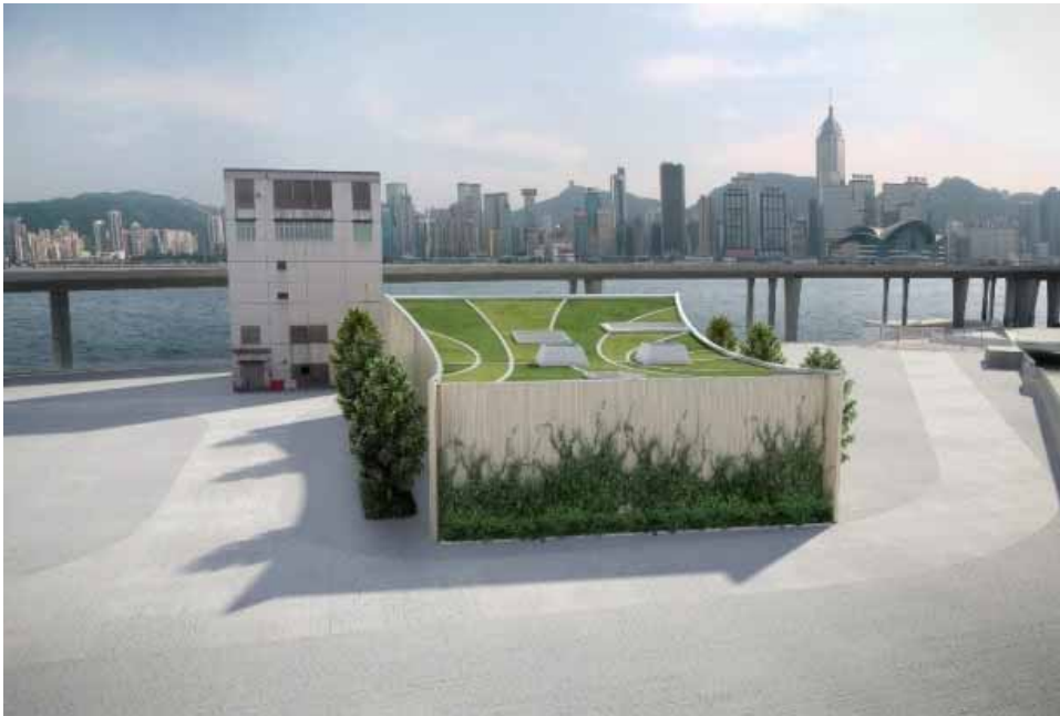
位於紅磡岸邊的通風大樓
