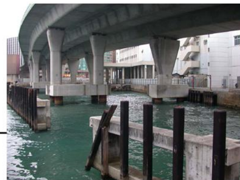
紅磡繞道防撞欄樁柱
